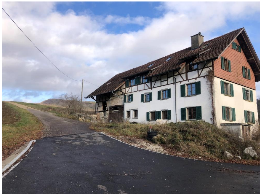
Abb. 7: Ansicht bestehende Gebäude VS Nr. 165 (Quelle: inexo)
